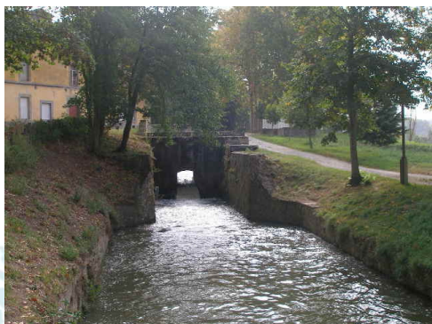
Déversement de la rigole dans le bassin de Naurouze (oct. 2007)
